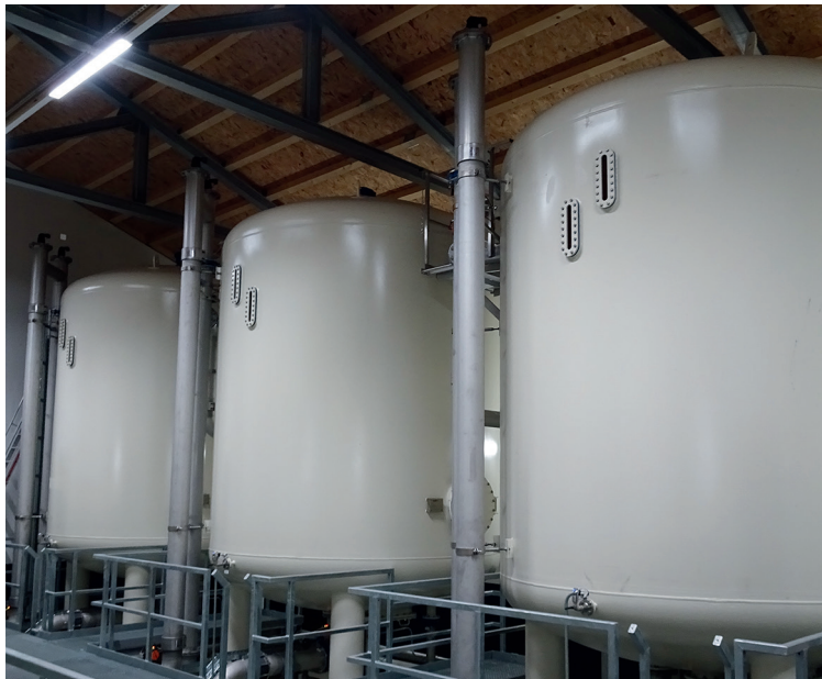
Schnellfilteranlage zur Enteisung und Entmanganung
