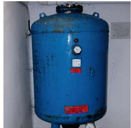
Abb.2: Korrosion und Rost
