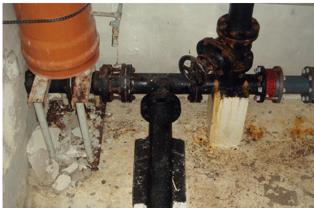
Abb.3: Durchfeuchtungsschäden
