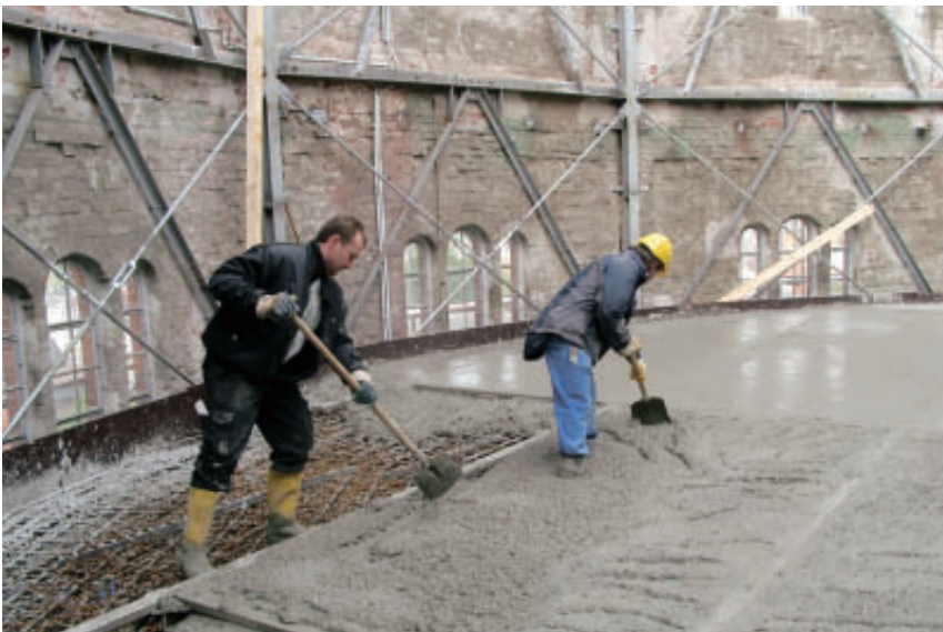
Abb. 6: Betonieren der Tragdecke, gut erkennbar sind die Edelstahlbodenschienen
