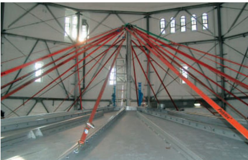
Abb. 7: Behälterdach bei der Montage
