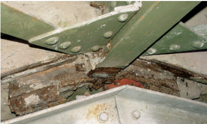
Abb. 3: Korrosionsangriffe an wichtigen statischen Bauteilen
