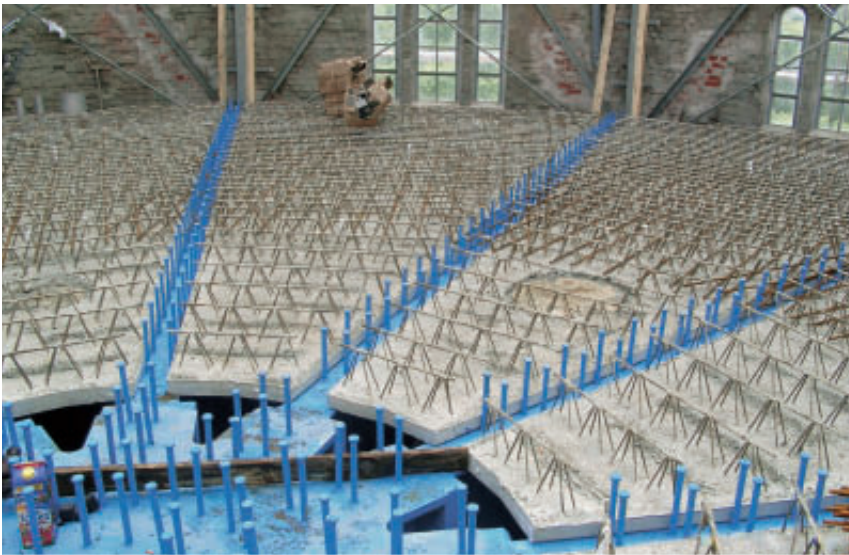
Abb. 5: Unterschalung aus Filigranelementen
