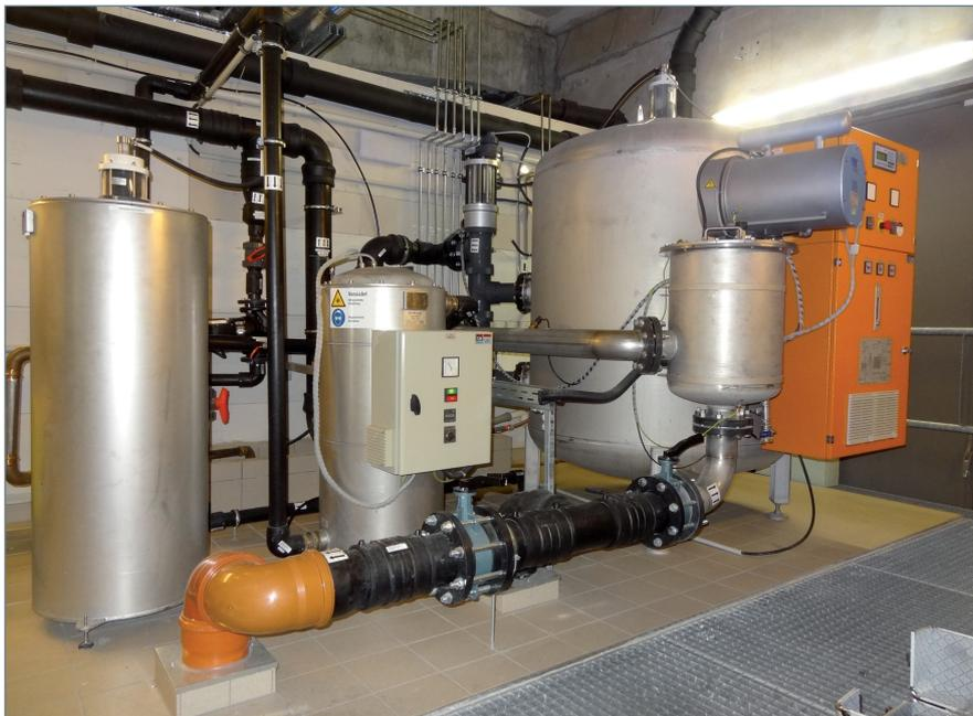
■ Abbildung 7: Hydrozon-Kompaktanlage mit Aktivkohlefilter und UV-Anlage (hier im Förderzentrum Hoyerswerda)
