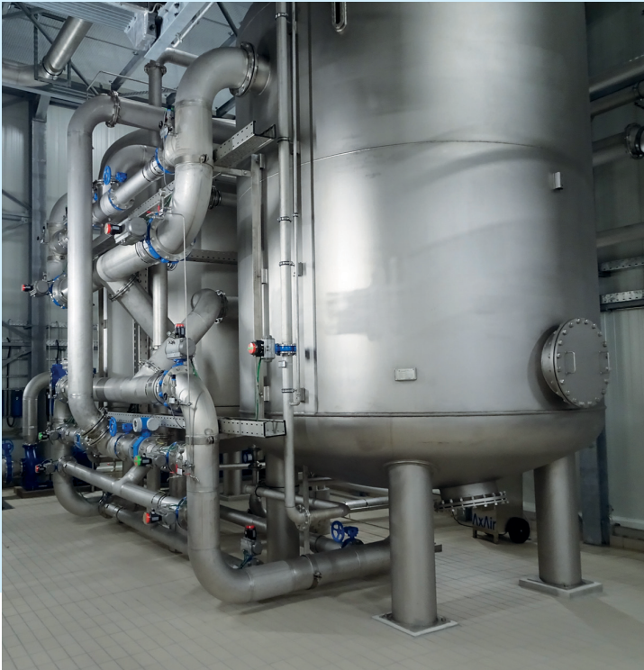
Bild 1 Wasserwerk Venningen: Die dem Oxidationsprozess nachfolgende Filtration erfolgt im Mehrschichtfilter.
