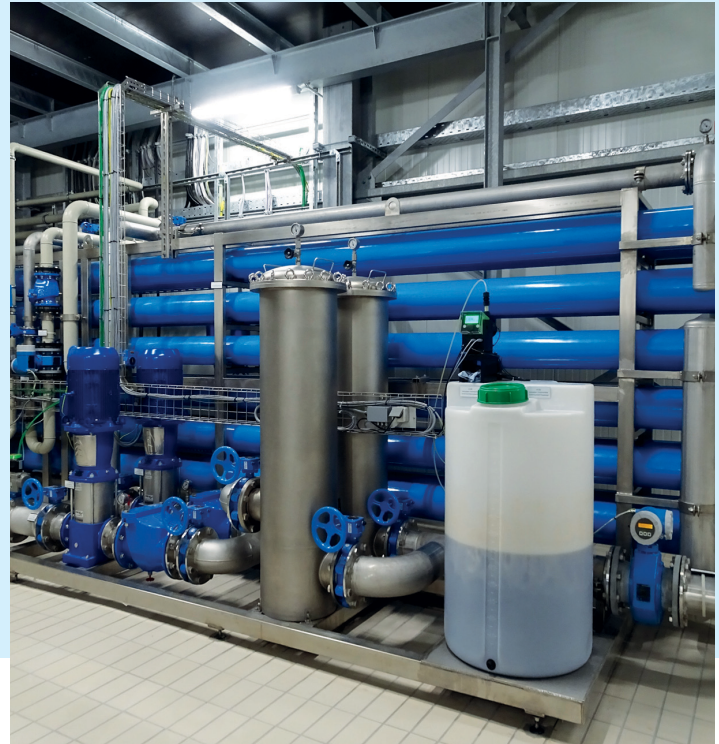
Bild 2 Die Enthärtung des Trinkwassers wird über eine Nanofiltrationsanlage vollzogen.
