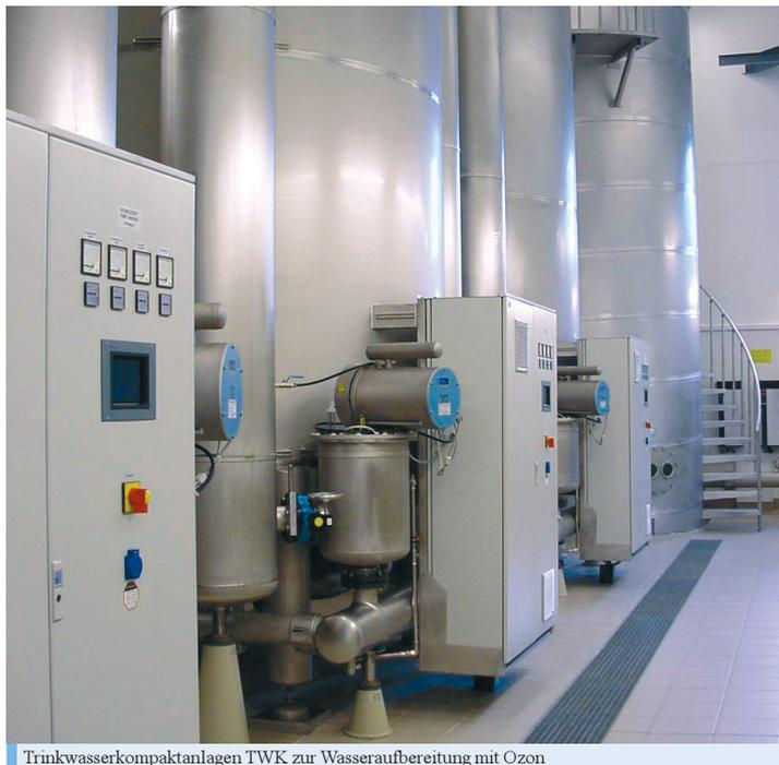
Trinkwasserkompaktanlagen TWK zur Wasseraufbereitung mit Ozon
