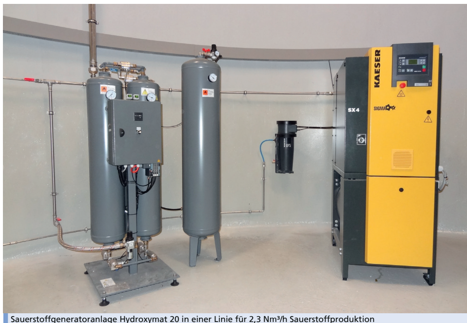
Sauerstoffgeneratoranlage Hydroxymat 20 in einer Linie für 2,3 Nm 3 /h Sauerstoffproduktion
