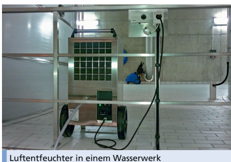
Luftentfeuchter in einem Wasserwerk
