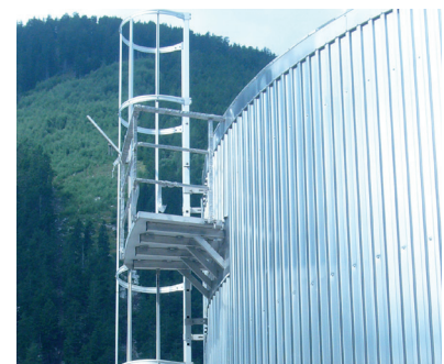
Leiter mit Dachzugang
