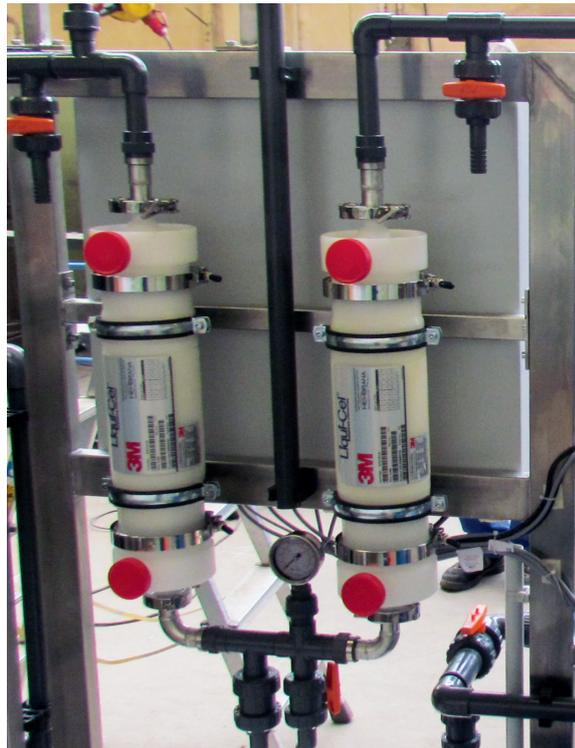
**Zweistufige Anlage mit Membrantgasern**
