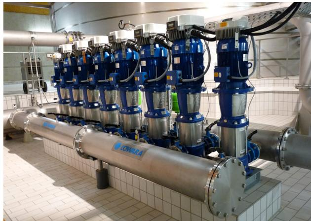
Druckerhöhungsanlage mit Frequenzumformern
