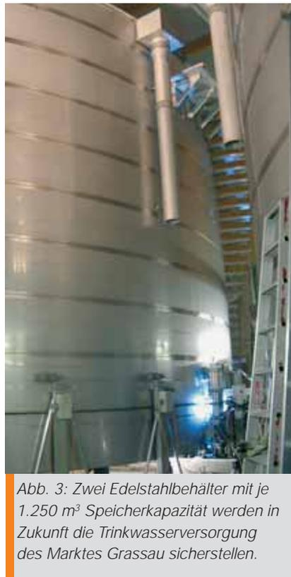
Abb. 3: Zwei Edelstahlbehälter mit je 1.250 m<sup>3</sup> Speicherkapazität werden in Zukunft die Trinkwasserversorgung des Marktes Grassau sicherstellen.
