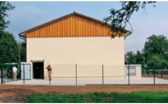
Abb. 5 Behälteranlage in Massivbauweise aus Betonfertigteilen
