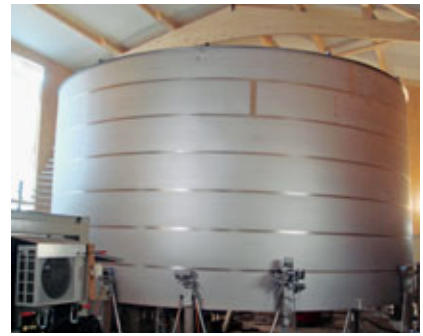
Abb. 7 HydroSystemTank 500 m 3 im Bau – Fertigung in Euskirchen
