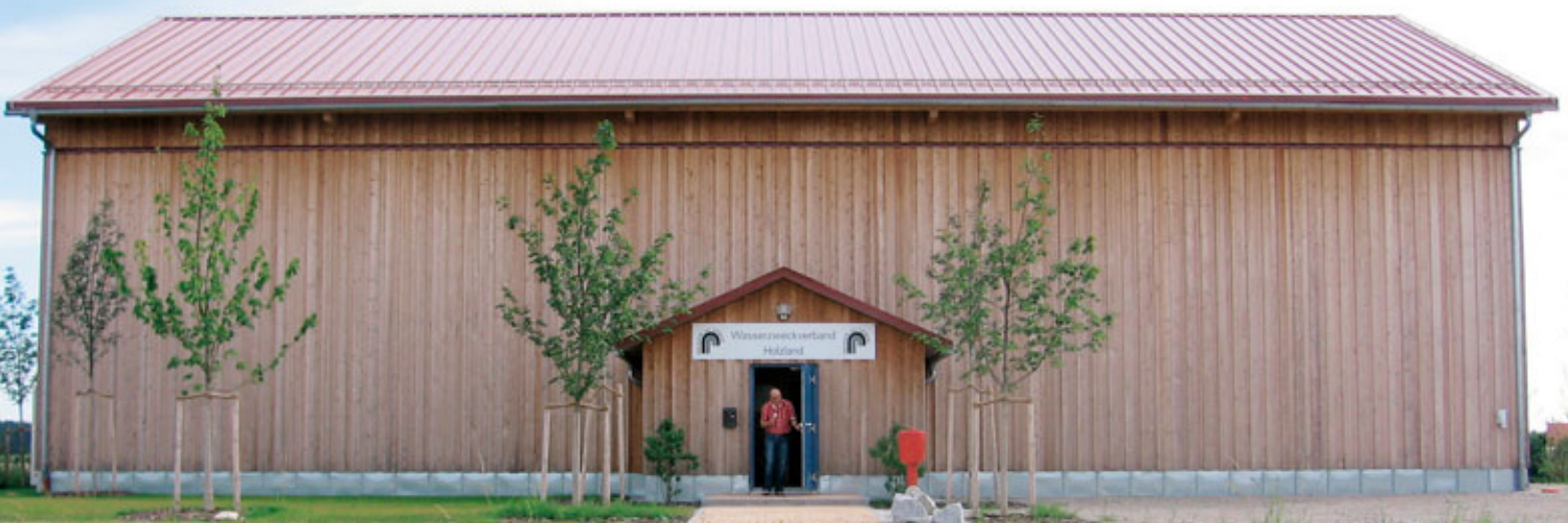
Abb. 1 Wasserwerk Holzland mit Aufbereitungsanlage, zwei Edelstahlbehältern mit je 750 m 3 sowie frequenzgesteuerter Druckerhöhungsanlage
