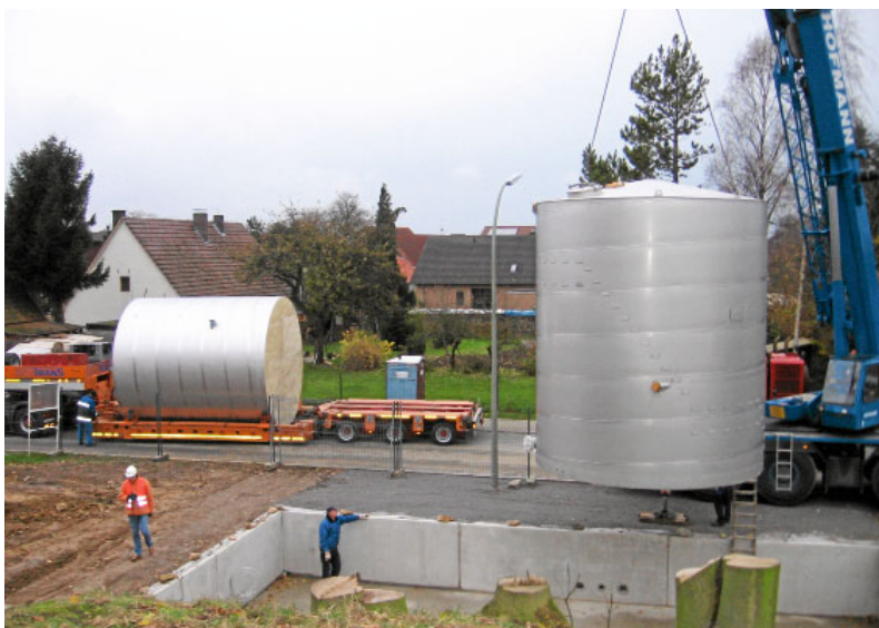
Bild 8. Transport und Aufstellung werkstofffertigter HydroSystem-Tanks.
