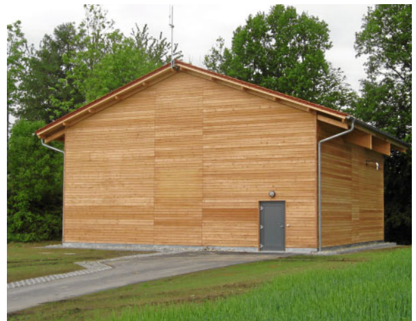
Bild 1. Hochbehälter Kapfel mit einem Edelstahlbehälter 400 m 3 .
