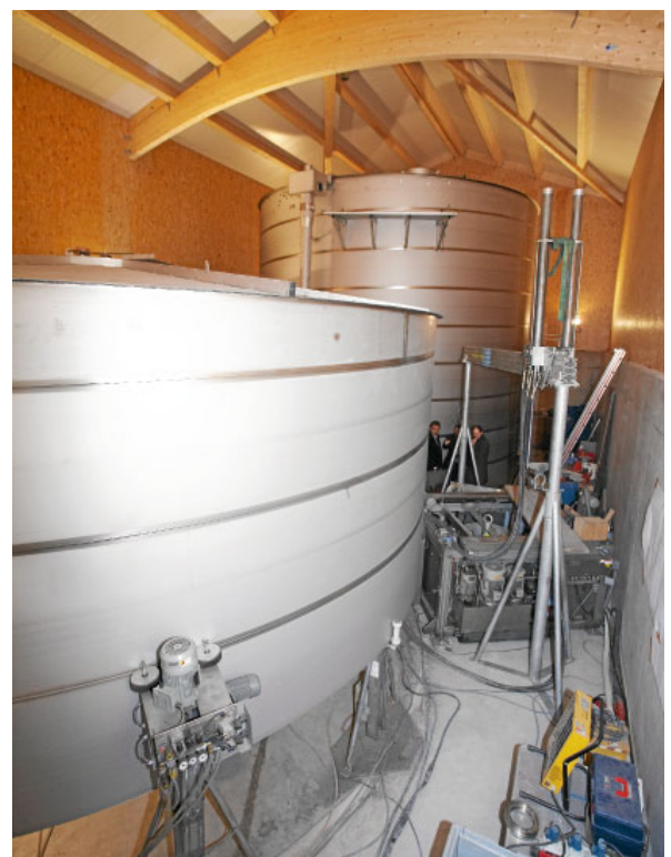
Bild 6. Fertigung der HydroSystemTanks vor Ort.
