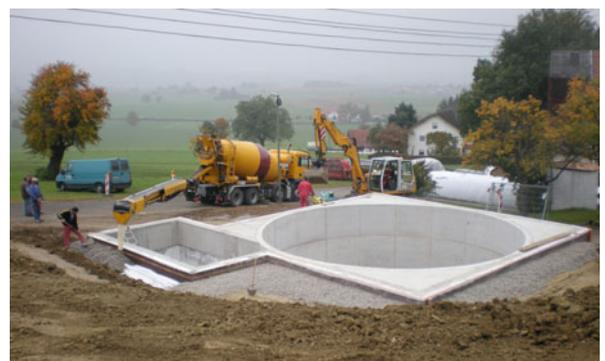
**Bild 3.** Unterteil nach Fertigstellung der Betonarbeiten.
