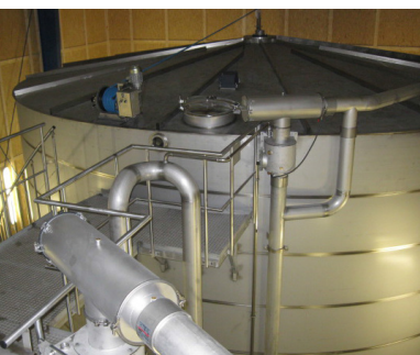
Abb. 9: Fertige Tanks mit Bedienpodest und Belüftungseinheiten
