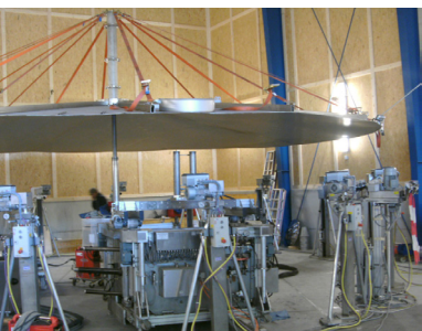
Abb. 6: Angehobenes Kegeldach für einen Edelstahltank, Vorbereitung Mantelschweißung
