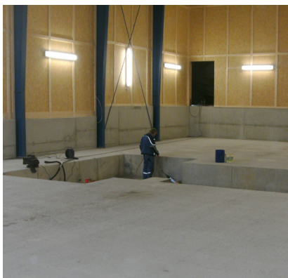
Abb. 4: Fertige Halle mit Betonwanne, OSB-Platten als Wandverkleidung und Rohrleitungskeller im zentralen Bereich
