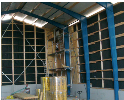
Abb. 3: Hallenbau in Stahlträgerkonstruktion mit Wandisolierung (Glaswolle)
