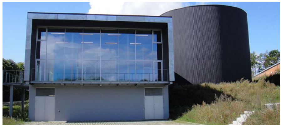
Bild 2: Wasserwerk Truelsbjerg, Aarhus-Dänemark – rechts Reinwasserbehälter 2 x 1000 m 3 . © Hydro-Elektrik GmbH
