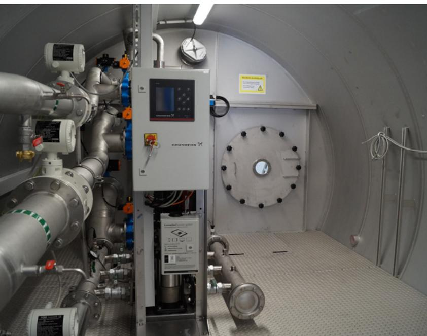
**Bild 2:** Quellsammelschacht im Rohrbehälter
