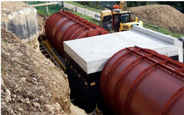
**Bild 1:** Röhrenbehälter in starker Hanglage auf 1200 m
