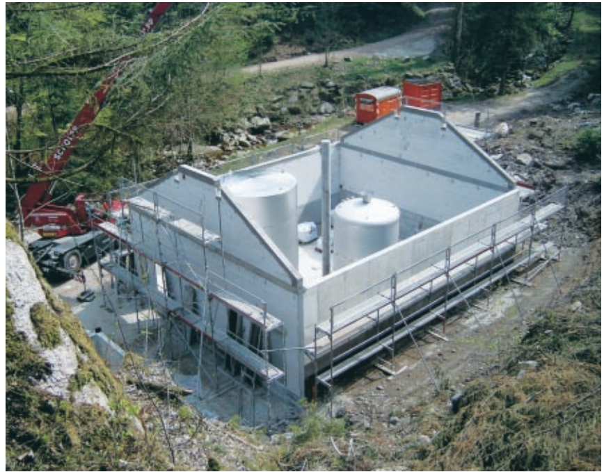
Abb. 3: Aufstellung der Filteranlage und des Reinwasserbehälters im neuen Wasserwerk
