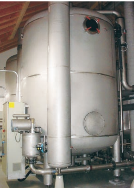
Abb. 4: HYDROZON®-Kompaktanlagen mit angebauten Ozonerzeugern und Kontaktkolonnen
