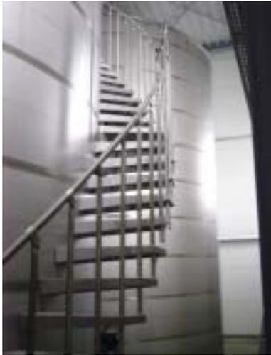
**Bild 5.** Reinwassertanks 2 x 200 m<sup>3</sup> aus Edelstahl.
