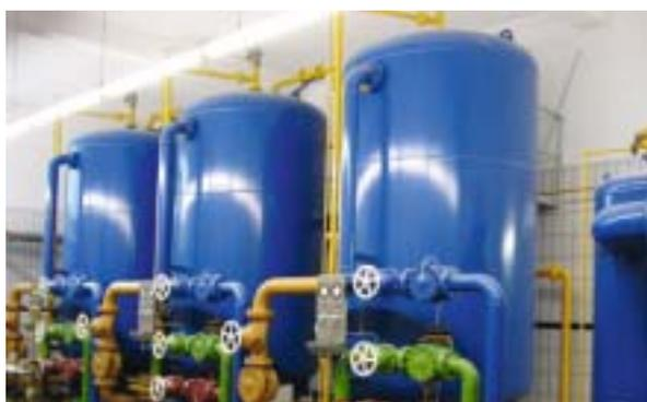
**Bild 2.** Bestehende Druckfilteranlage zur Entsäuerung, Enteisenung und Entmanganung. Quelle: Hydro-Elektrik GmbH
