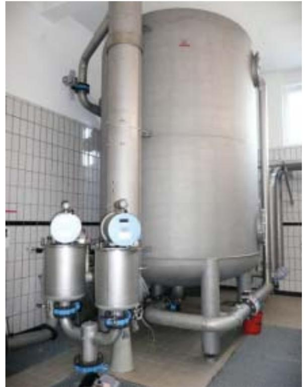
**Bild 8.** Ozon-Biofiltrationsanlage TWK 70/40.
