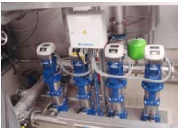
**Bild 7.** Kompaktdruckerhöhungsanlage 4 x 25 m<sup>3</sup>/h bei 4 bar. Quelle: Hydro-Elektrik GmbH
