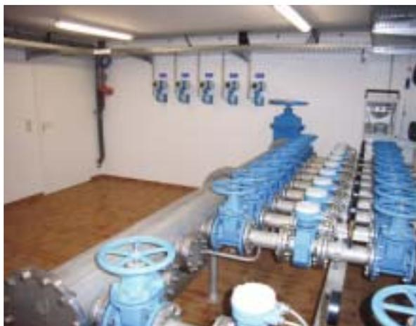
**Bild 1.** Messung und Zusammenführung der Rohwässer. Quelle: Hydro-Elektrik GmbH
