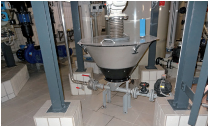
Abb. 3 - Feststoffpumpe zur Sandeinspülung
