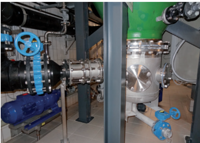
Abb. 4 - Einströmung SEK-Reaktor und Pelletsabzugpumpe
