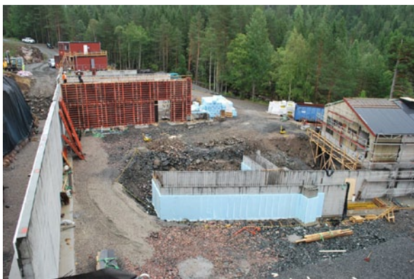
Bild 2. Neubau Wasserwerk mit bestehendem Maschinenhaus. © Sweco
