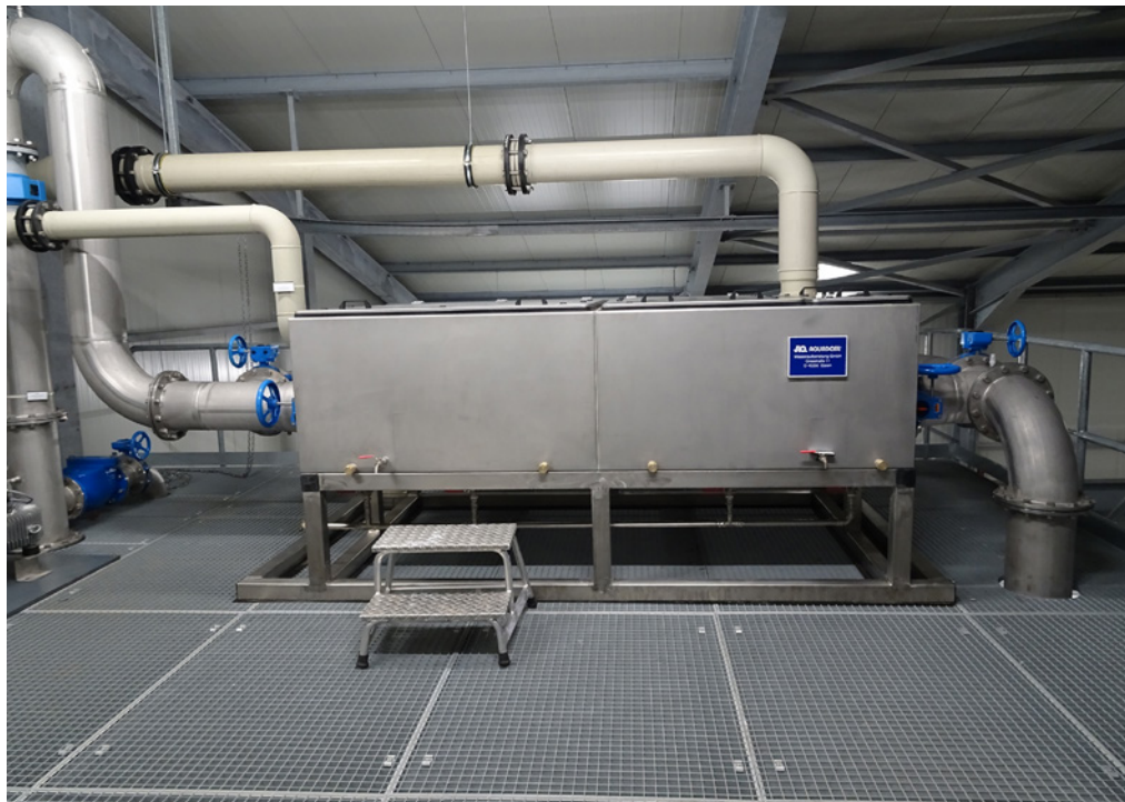
Abb. 4 – Der Flachbettbelüfter konnte aus der alten Anlage übernommen und im neuen Wasserwerk Veningen integriert werden.
