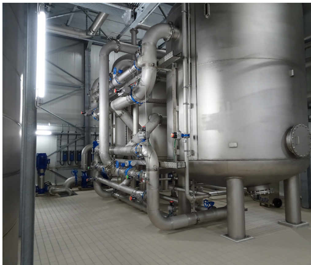
Abb. 1 – Mehrschichtfilteranlage mit Quarzsand und Filterkohle als Filterschichten
