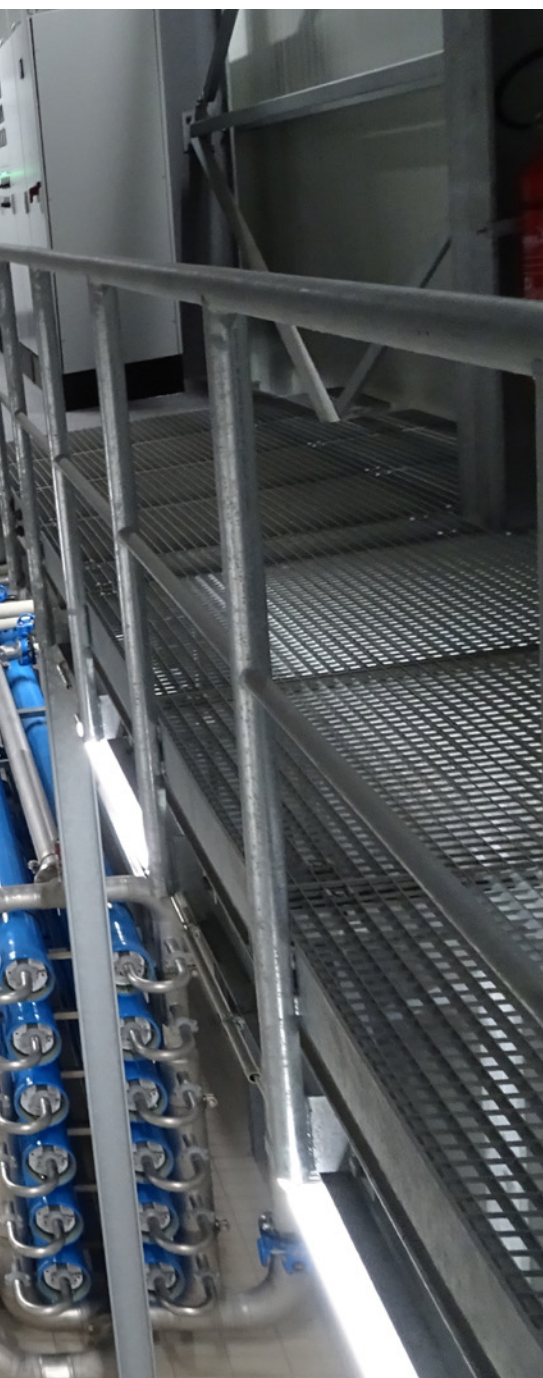
Abb. 1 – Mehrschichtfilteranlage mit Quarzsand und Filterkohle als Filterschichten
