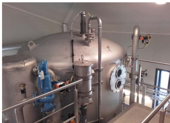
Bild 3: Biofilter in Furusjøen vannverk
