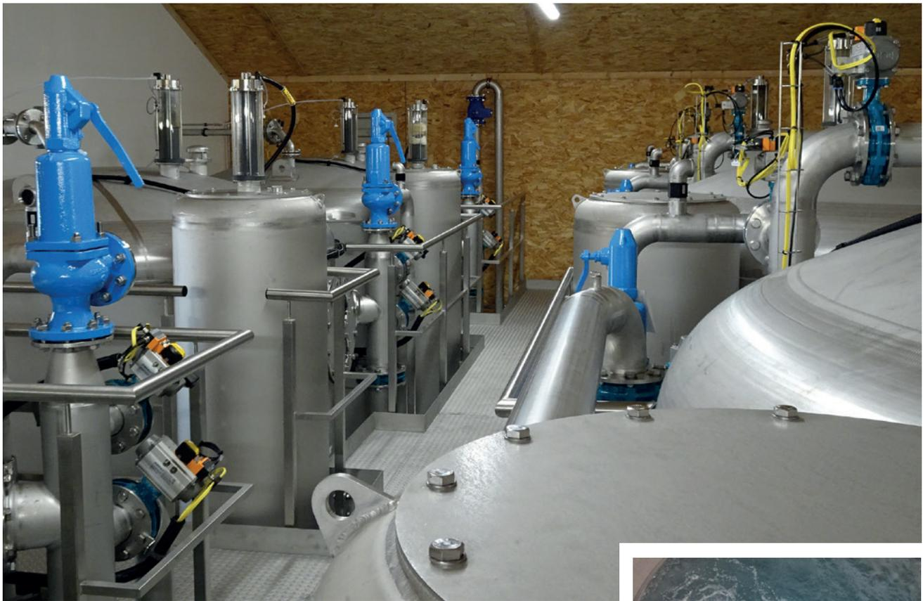
Abb. 4: Filterbehälter des neuen Wasserwerks
