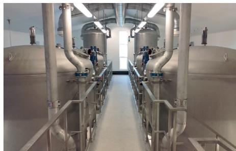
Die in zwei vollständig getrennten Linien aufgebaute Anlage ist für eine Aufbereitungsleistung von 80 m<sup>3</sup>/h konzipiert. Die Verfahrensschritte sind CO<sub>2</sub>-Anreicherung - Ozonisierung - Kontaktkolonnen (D = 1300, H = 6000 mm) - Aufhängung über Marmorfilter (D = 2500, H = 4000 mm) im Aufstrom - Mehrschichtfiltration (D = 3000, H = 4000 mm) zur Biofiltration und Partikelabtrennung im Abstrom - UV-Bestrahlung.
