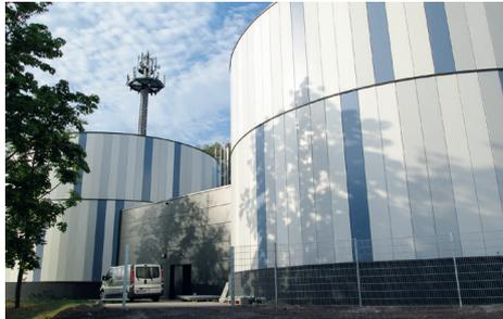
Im ersten Bauabschnitt wurden zunächst zwei zusätzliche Edelstahlbehälter mit 15,75 Metern Durchmesser und je 1500 m<sup>3</sup> Inhalt errichtet und hydraulisch und elektrisch in das System integriert. Die mit modernster Luftfiltertechnik ausgestattete Behälter-
