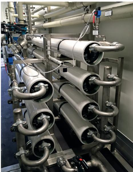
Der ReinstWasserTrailer erzeugt zuverlässig 20 m³/h Deionat in VGB-Reinstwasserqualität. Selten erforderliche Wechsel der Filterkerzen und ein Nachfüllintervall der Prozesschemikalien von einigen Tagen bedeuten einen geringen Personalaufwand für den Kunden. Darüber hinaus sind aufgrund der überdimensionierten Mischbettfilter sehr selten RWT-Wartungseinsätze für Mischbettfilterharz-Wechsel fällig.
