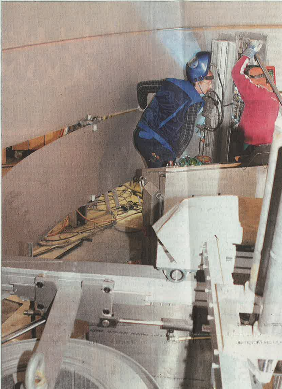
Die Arbeiter der Firma „Hydro-Elektrik“ schweißen den neuen Edeltank (großes Foto) in Kommern zusammen. Im Inneren des 500 Kubikmeter fassenden Tanks erläutert Manfred Brugger (o.r.) das Herstellungsverfahren. Aufsichtsratsvorsitzender Hans-Josef Engels (u.r.) und Architekt Bert Grafen inspizieren die Baustelle in Bleibuir. (Fotos: Düster)
