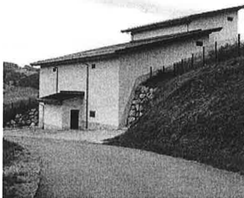
Der neue Hochbehälter am Ensenberg | Foto: Nikolaus Bayer
