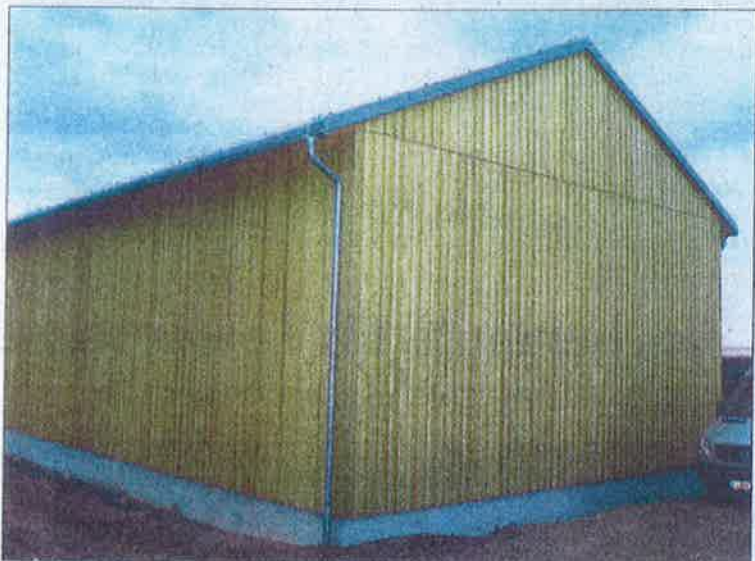
Die Behälter, auf diesem Foto auf der „Laangwiss“ bei Beyren, werden in einem zuvor errichteten Gebäude hergestellt.
