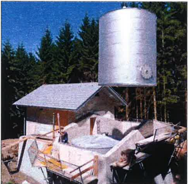
Der Ausbau des Trinkwasserhochbehälters Kirchhöf geht zügig voran.
