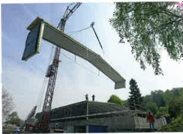
Die 17 Bauteile des Dachs werden mit einem Spezialkran auf das Fundament gesetzt.
