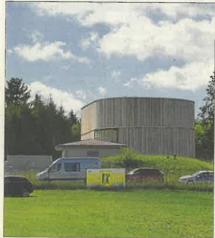
900 anstatt 500 Kubikmeter Wasser soll der neue Hochbehälter in Gottmannshofen fassen.
