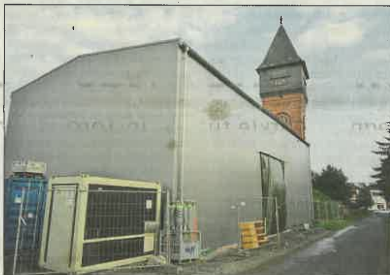
Die Halle mit den neuen Trinkwasserbehältern entsteht hinter dem alten Wasserturm, der noch genutzt wird. Fotos: Daniel Lüns
