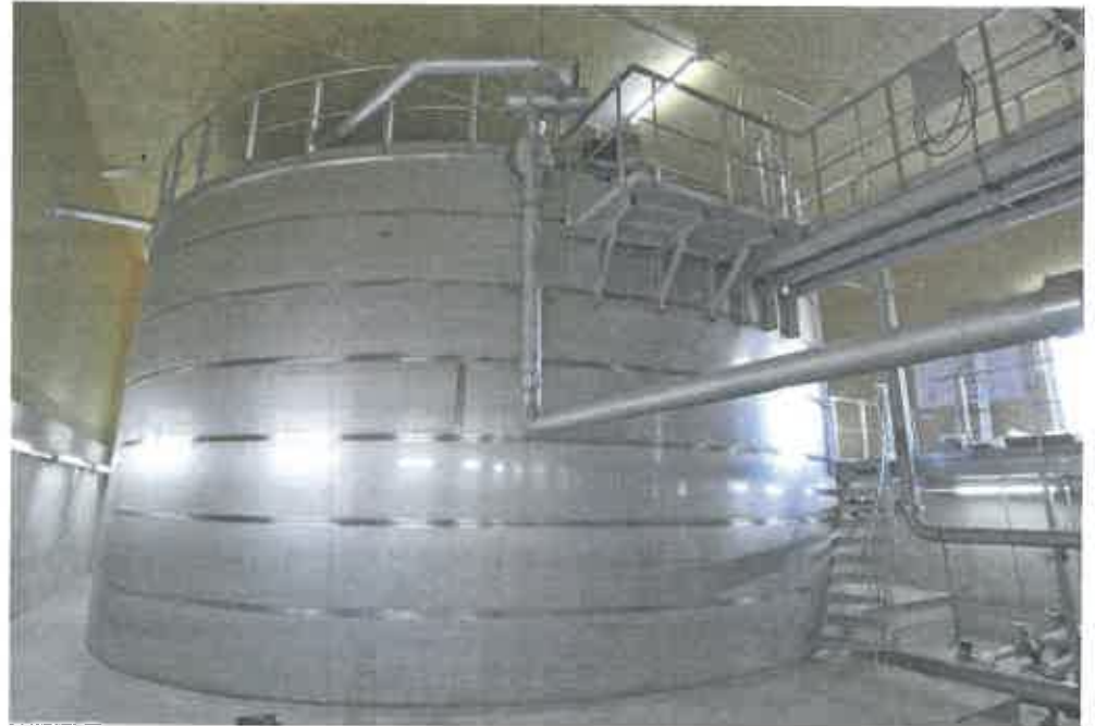
Jeweils 500 Kubikmeter Wasser nimmt jeder der beiden Tanks auf. Der Durchmesser beträgt jeweils 11,50 Meter. Fotos: Olaf Winkler
