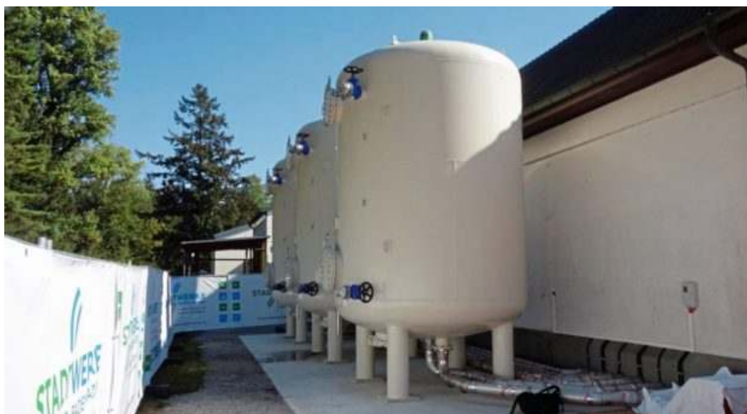
Aktivkohlefilter: Sie reinigen das mit PFC-belastete Spülwasser vor der Einleitung in den Sandbach. | Foto: Rudolphi
