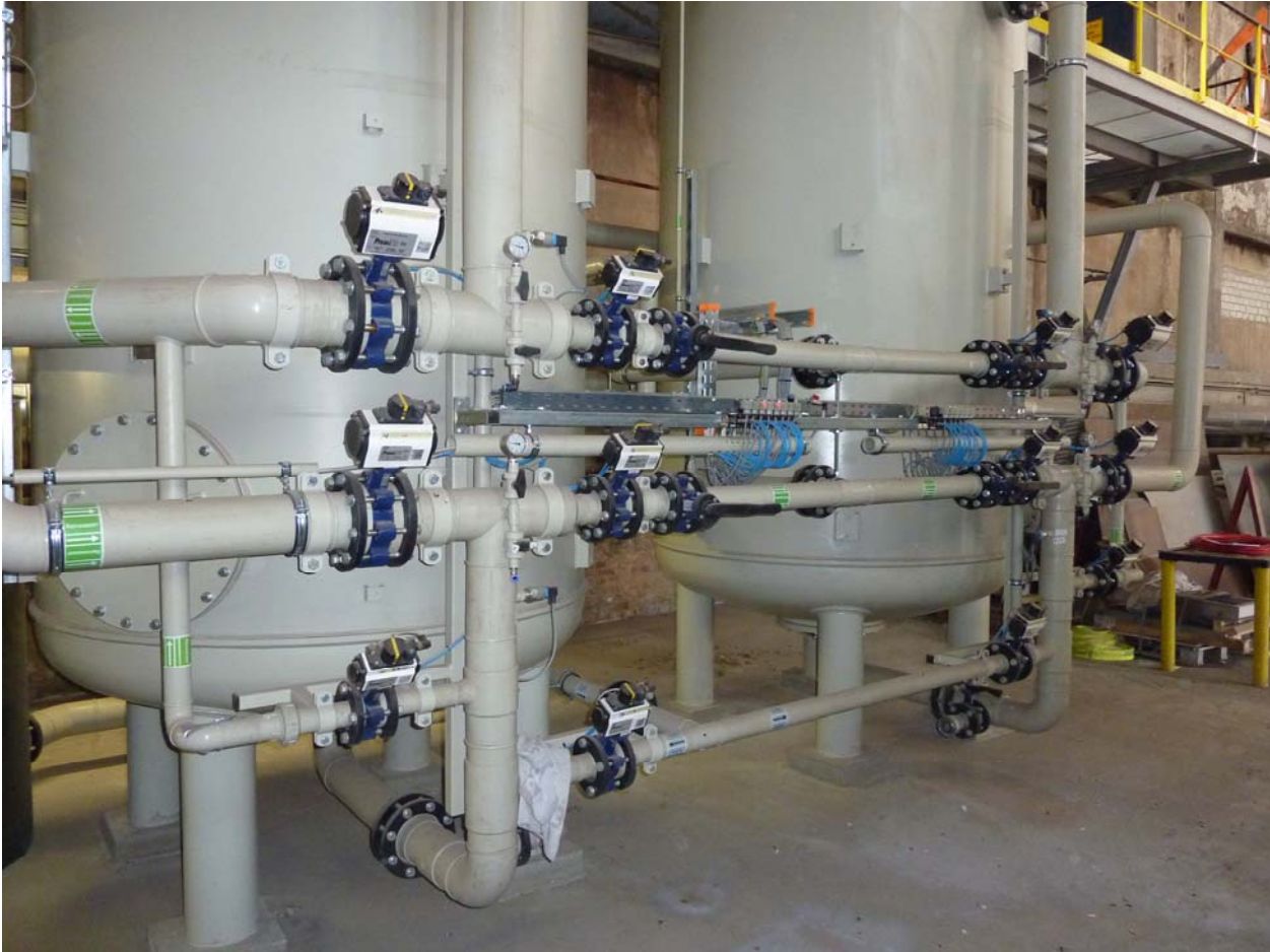
Mehrschichtfilter
