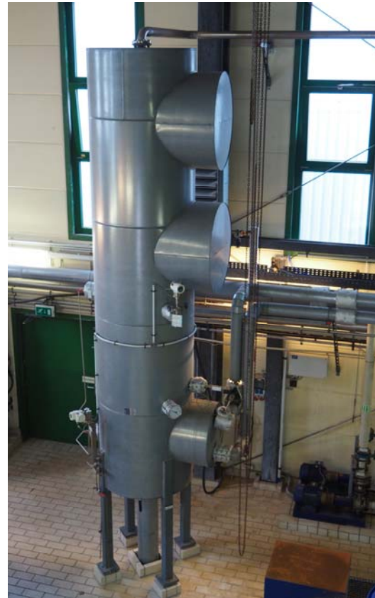
Vakuumentgaser aus Edelstahl, isoliert
